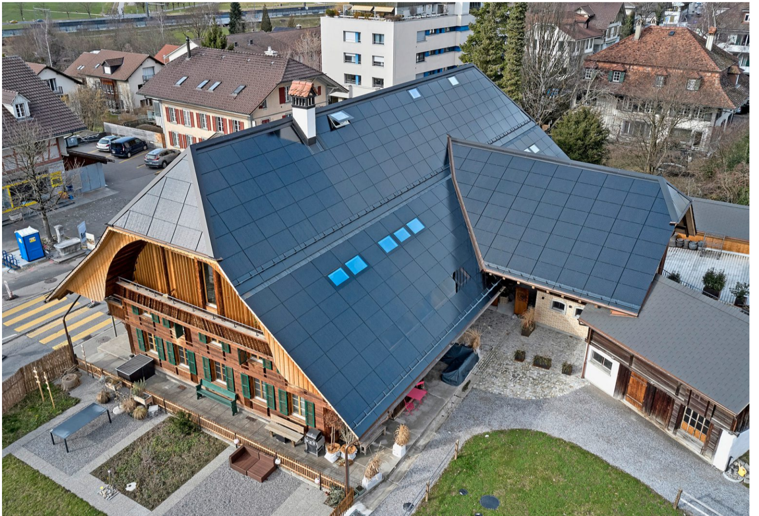
Das schwarze Solardach wirkt auf dem alten Holzhaus geradezu elegant. Foto: Adrian Moser
